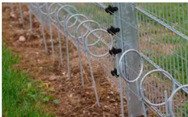
Elektrisk hegn med sikring mod undergravning.
